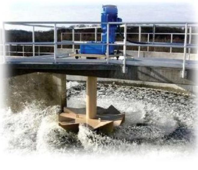
شرکت سیال کاران با دارا بودن تجهیزات برش، جوش کاری و بالاسینیگ و رنگ آمیزی پوکسی، انواع توربین های هوادهی سطحی ثابت و متحرک با جنس استیل یا ST37 را تولید می نماید.
